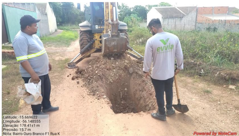
Coleta dos furos de sondagem
