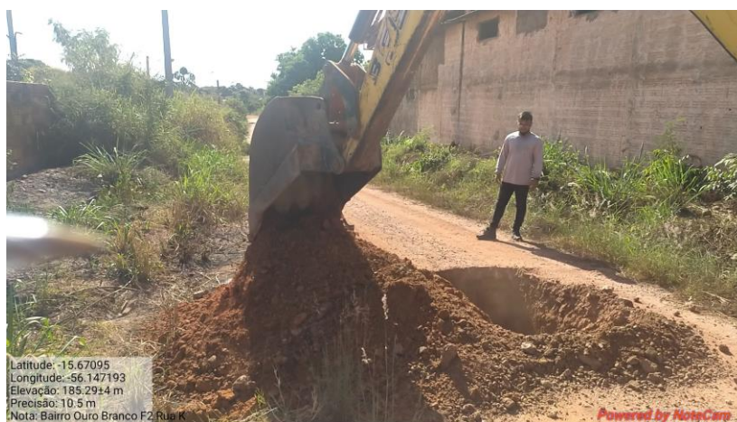
Coleta dos furos de sondagem
